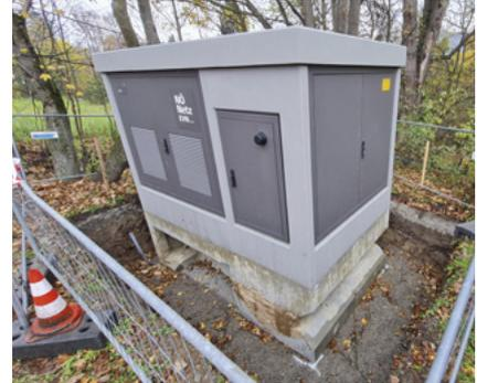
Die erste neue EVN-Trafostation für die Netzzumrüstung der Stadt wurde geliefert und vormontiert. Sie befindet sich hinter der Altglassammelstelle beim Raabsertor und wird den in die Jahre gekommenen Hochtrafo gegenüber ersetzen. Ziel ist es, die Überlandleitung zur Versorgung von Autendorf durch ein Erdkabel zu ersetzen und die Einspeisung von privatem „grünen“ Strom zu ermöglichen. Der Trafo für den Hauptplatz wurde bestellt.
