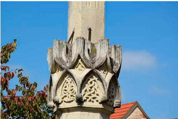
Auf der zierlich gearbeiteten Säulenkrönung erhebt sich der **obere Säulenschaft**. Er ist vierseitig, 32 cm stark und einschließend des 40 cm hohen Trapezkapitells, auf dem der Ritter steht, etwa 1,8 Meter hoch. Dieser obere Teil mit dem „steinern Mann“ wurde 1616 angefertigt, da die alte Figur von einem „großen Sturmwind“ heruntergeworfen worden war.
